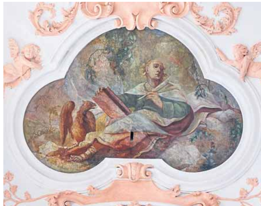
Vorher und nachher: Stuck und Fresken zeigten schwere Beschädigungen – gut zu sehen am Beispiel der Darstellung des Evangelisten Johannes, zu finden in einem der Trabantenfelder des Deckenbildes östlich der Vierung. Hier waren umfangreiche Restaurierungsarbeiten nötig. Fotos: Staatliches Bauamt; Marcel Peda
