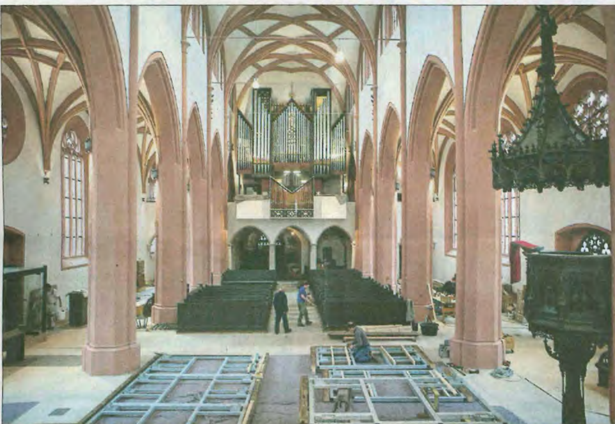
Sieht ja schon wieder fast aus wie früher. Aber eben nur fast: die Kanzel (rechts) hat die Seiten gewechselt, die Bankpodeste (im Vordergrund) werden durch einen Rollmechanismus verschiebbar gemacht. Fotos: Waha
