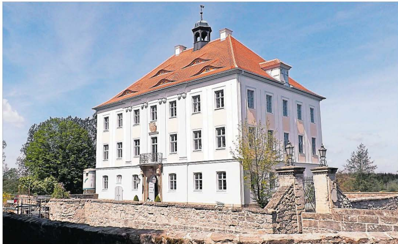
Das Schloss Rammersdorf: Jahrelang waren dort die Handwerker im Einsatz. Nun sind die Bauarbeiten an der Fassade und im Inneren abgeschlossen – und die Familie von Markus Freiherr von Eyb hat ihre Privatsphäre wieder. Foto: Diane Mayer
