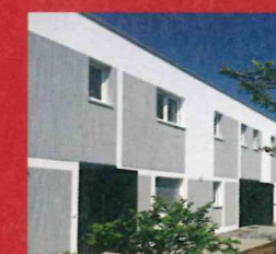
Mit handwerklichem Geschick und mineralischen Putzen von Keim wertete die Firma Form und Farbe Ehmann die schlichte Gebäudeform dieses Mehrfamilienhauses in Erlangen mit Teilflächen in Kammzugtechnik auf
