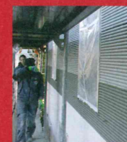
Um den Kammzug über eine gesamte Gebäudelänge gerade und gleichmäßig ausführen zu können, sind Holzkonstruktionen als Führungshilfe des Kammzugwerkzeugs hilfreich
