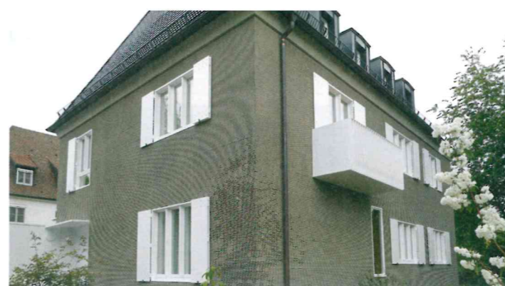
Kammzugtechnik Mit einem Stahlkamm oder Sägeblatt werden waagerechte, senkrechte oder wellenförmige Linien in den Putz gezogen. Der Kammzug kann Band für Band freihändig oder auf einer vorher nivellierten Holzkonstruktion abgezogen werden. Es entsteht – anders als bei dem üblichen dreiecksförmigen Profil – die Struktur einer gezahnten Briefmarke, mit feinen negativen Fugen und einer breiteren halbkreisförmigen Bänderung
